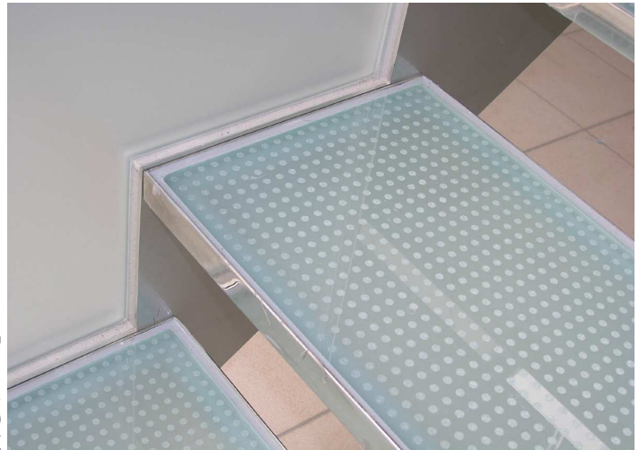
ステンレス手摺 ステンレスササラ 踏板：強化合わせガラス (滑り止め加工) 世田谷区
