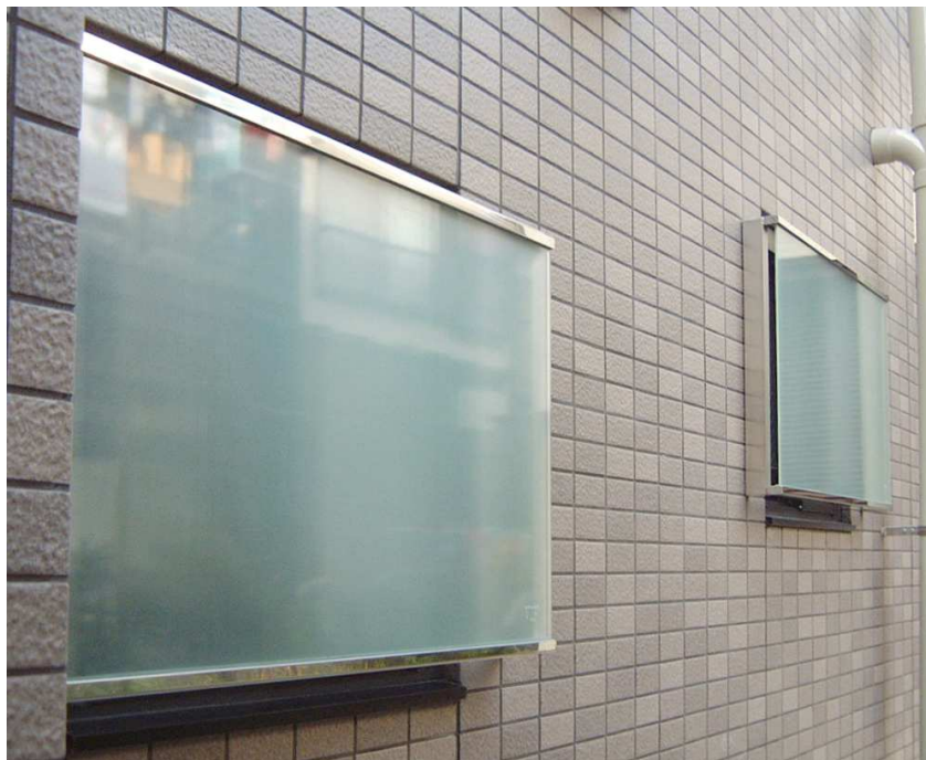
MH-GMS MRG-C1303-44F 川口市
